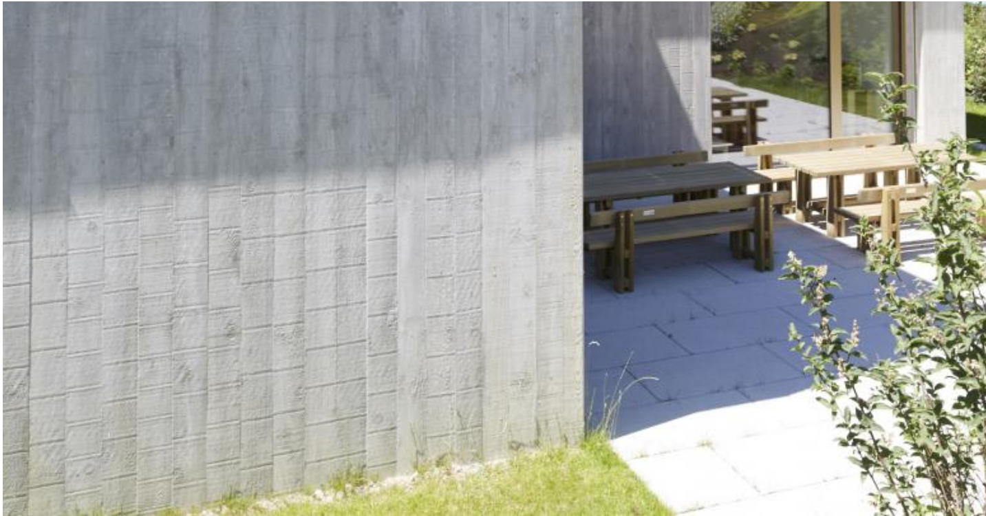
Fassadendetail (Foto: Heinz Unger)
